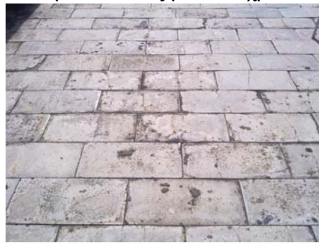
Εικόνα 2. Εξηλασμένο πολυστυρένιο με επίστρωση τσιμεντοκονίας μετά 10 χρόνια
