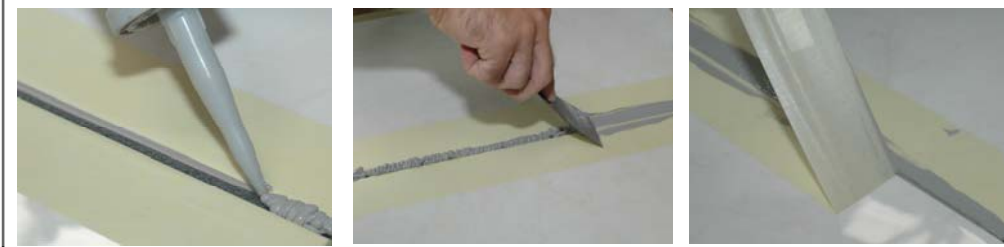
Εικόνα 12. Ελαστική σφράγιση αρμών διαστολής
